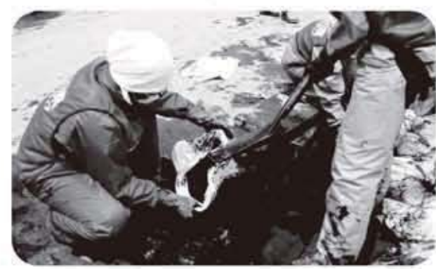
側溝の泥を土のう袋に詰める作業
