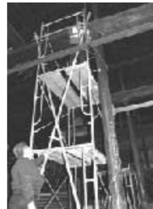
能登半島地震によって建物傾いたため、内部を鉄骨の足場で補強した
