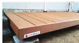
— ウッドデッキを設置 —
