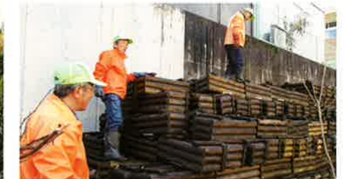
プランター撤去(12/2)
